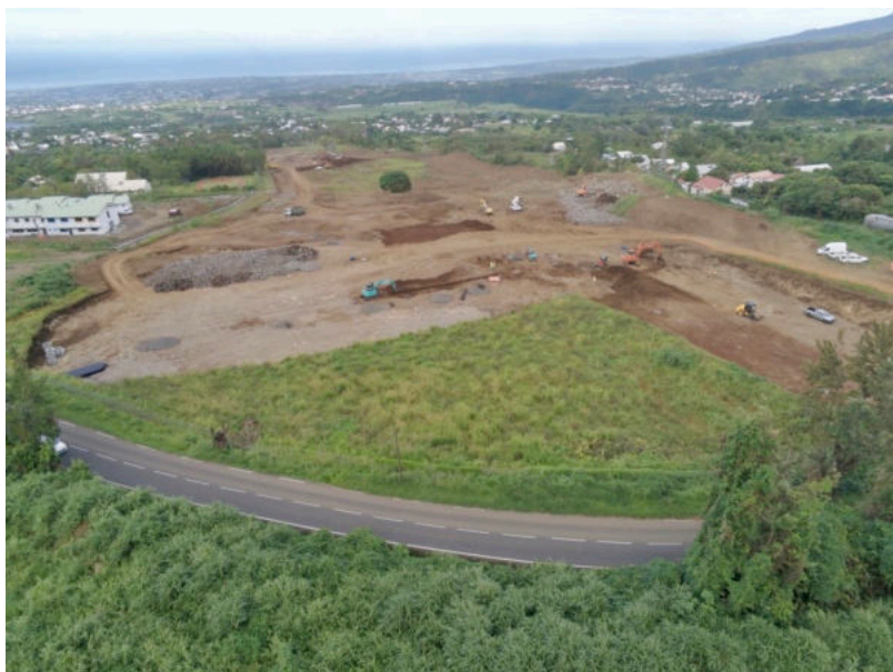
Vue aérienne des travaux d'extension du Parc en mars 2022
